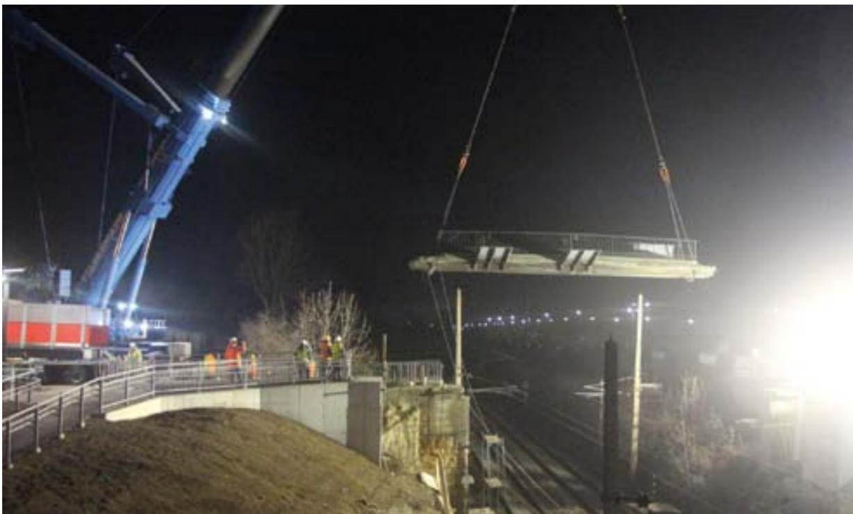
*Es war beeindruckend, mit welcher Präzision dieses enorme Bauwerk mit einem Gewicht von 20 Tonnen in weniger als einer halben Stunde eingehoben und befestigt wurde. Hier waren Spezialisten am Werk, die nur wenige Millimeter kleine Toleranzbereiche zur Verfügung hatten.*
